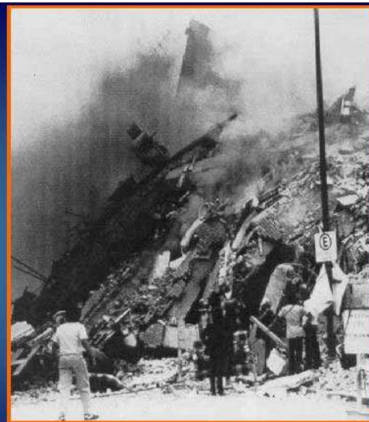
Edificio derrumbado en la calle San Juan de Letrán en el Distrito Federal. (Foto: Mühener Rückversicherungs- Gesellschaft.)
