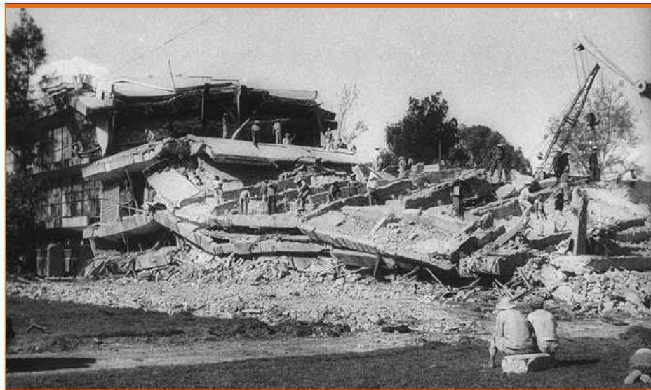
Colapso del ala sur del edificio IPN a causa del sismo de 1957 (Foto: L.C Barajas Earthquake Engineering Research Center)
