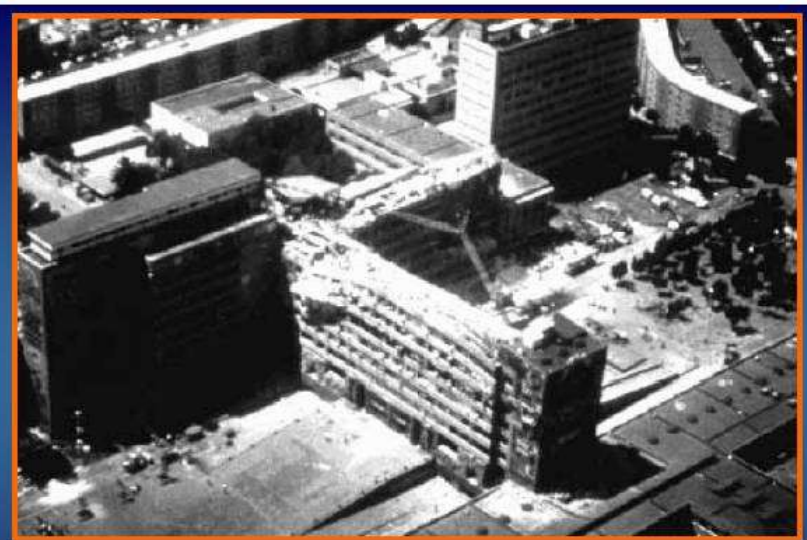
Daños en el Edificio de la Secretaría de Comunicaciones y Transportes
